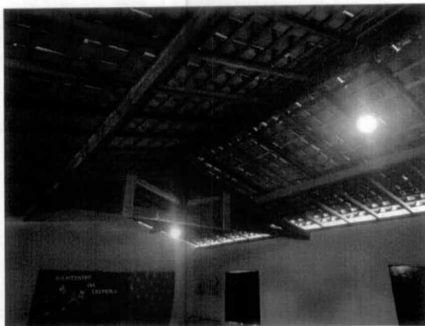
Imagem 4 – Revisão de Cobertura
