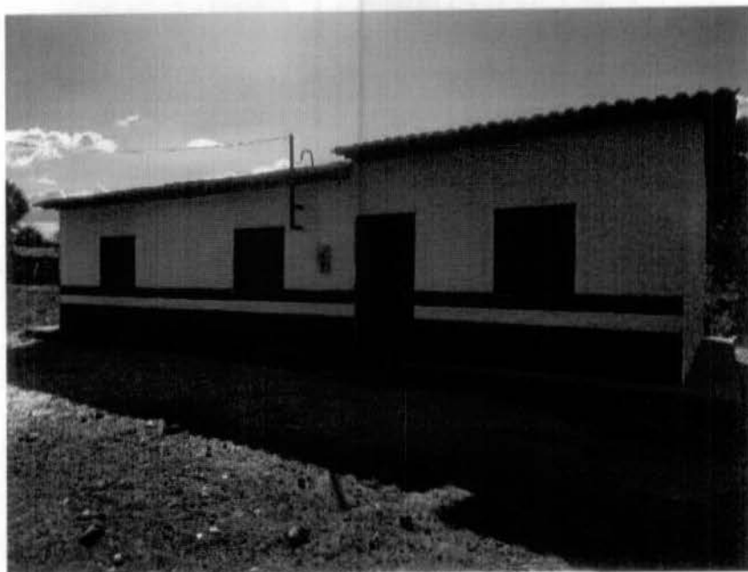
Imagem 2- Pintura Externa Executadas
